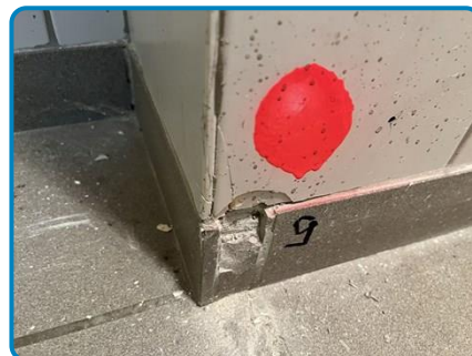
PRLV n° 9 sur Plinthes Carrelées Colle
