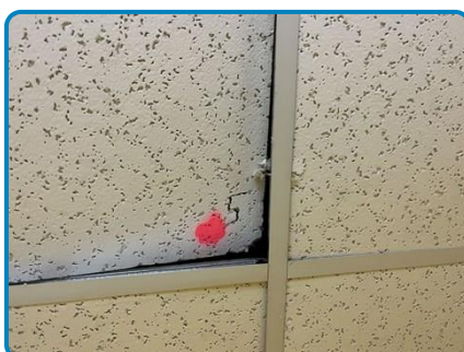
PRLV n° 5 sur Faux Plafond dalles Cartonnées
