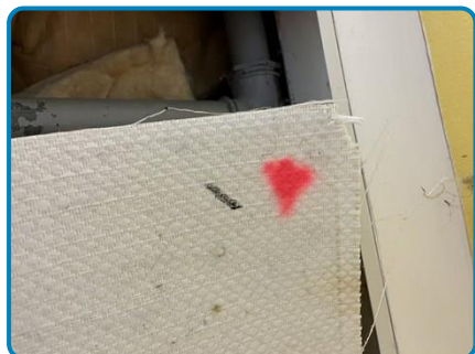
PRLV n° 1 sur Faux Plafond dalles isolantes
